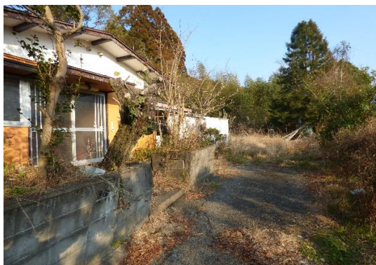
物件西側から物件を撮影
