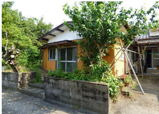
物件南側から物件を撮影②
