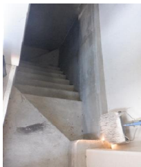
地下への階段降り口
