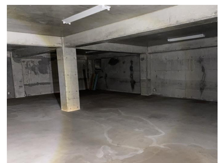
地下室東南側
