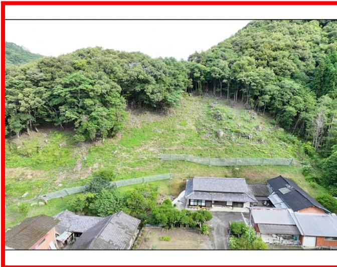
①本工事は人家裏の山腹斜面で発生した落石に対して、ロープ伏工及び落石防護柵工を施工したものである。当該箇所の山腹上部斜面には、広範囲に転石があるため施工期間を通した安全の確保が課題であったが、転石の状況把握や落石発生時の通報体制に務めたほか、安全面に配慮した仮設計画や綿密な作業工程に取り組み、無事故で早期に完成させた。
