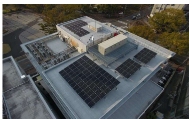
1-(2) 7号館屋上に太陽光パネル設置
