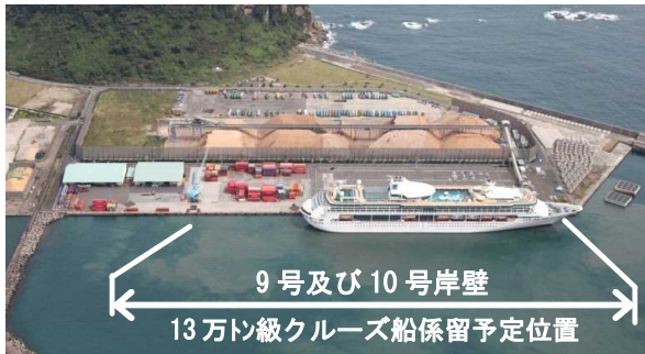
写真：レジェント・オブ・ザ・シーズ号接岸状況
