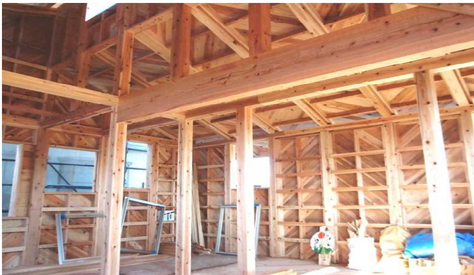
県産材を活用した住宅の建設現場
