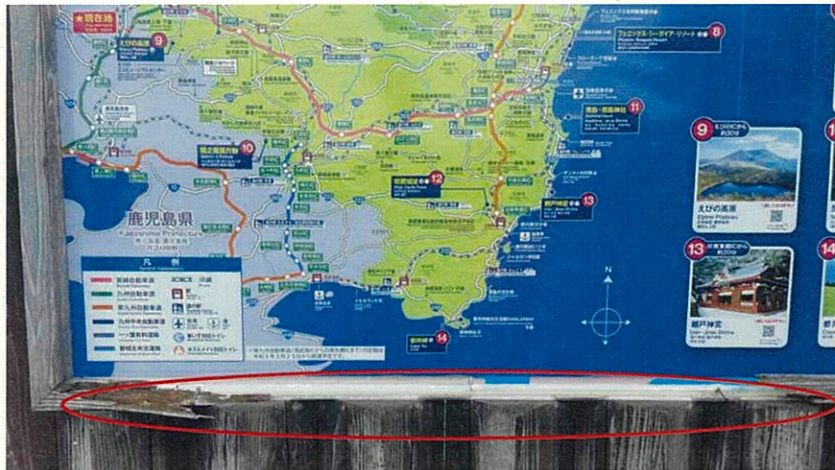
枠が腐食し釘がむき出しになっている
