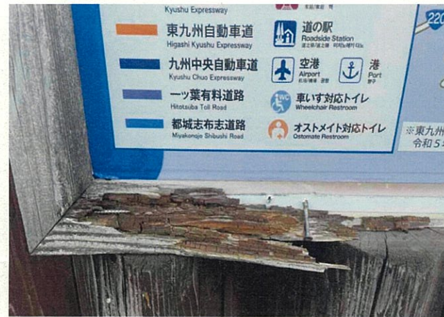
枠が腐食し釘がむき出しになっている
