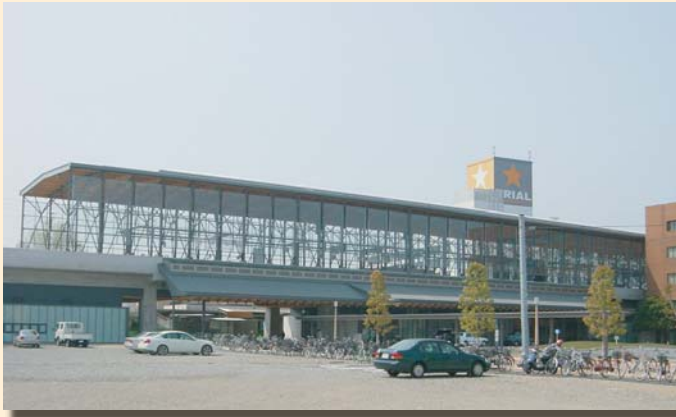
写真 1 日向市駅舎外観
