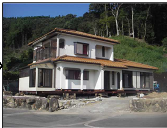
② 基礎の切り離し完了 所有者で実施
