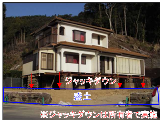
④ 盛土完了 県で実施
