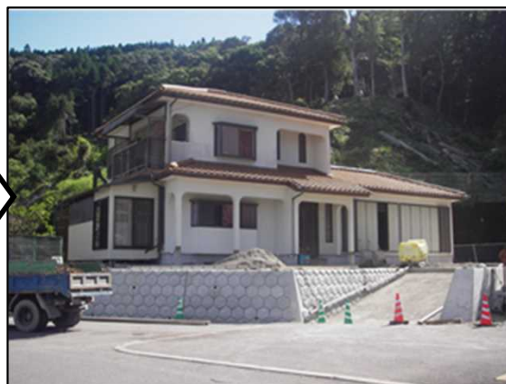
⑤ 擁壁完了 県で実施
