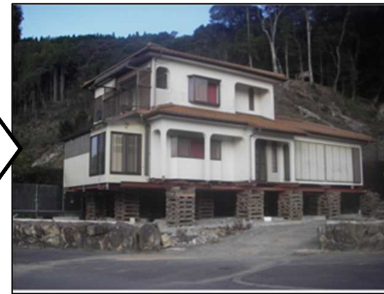
③ ジャッキアップ完了 所有者で実施
