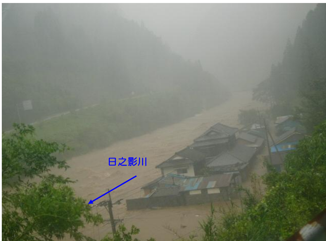
平成 17 年（2005 年）9 月洪水による支川日之影川沿い ひのかげ 日之影地区の被災状況
