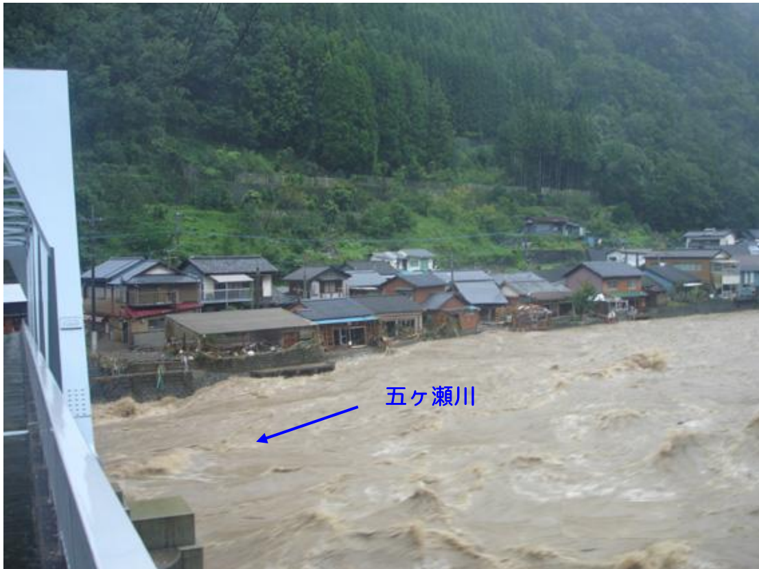
平成 17 年（2005 年）9 月洪水による五ヶ瀬川本川沿い ひのかげ 日之影地区の被災状況
