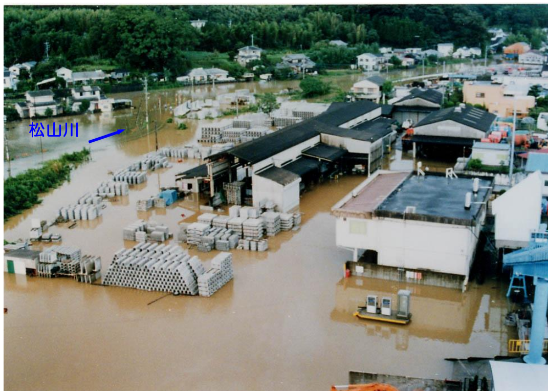
平成 9 年（1997 年）9 月洪水による支川 まつやま 松山川下流部の被災状況
