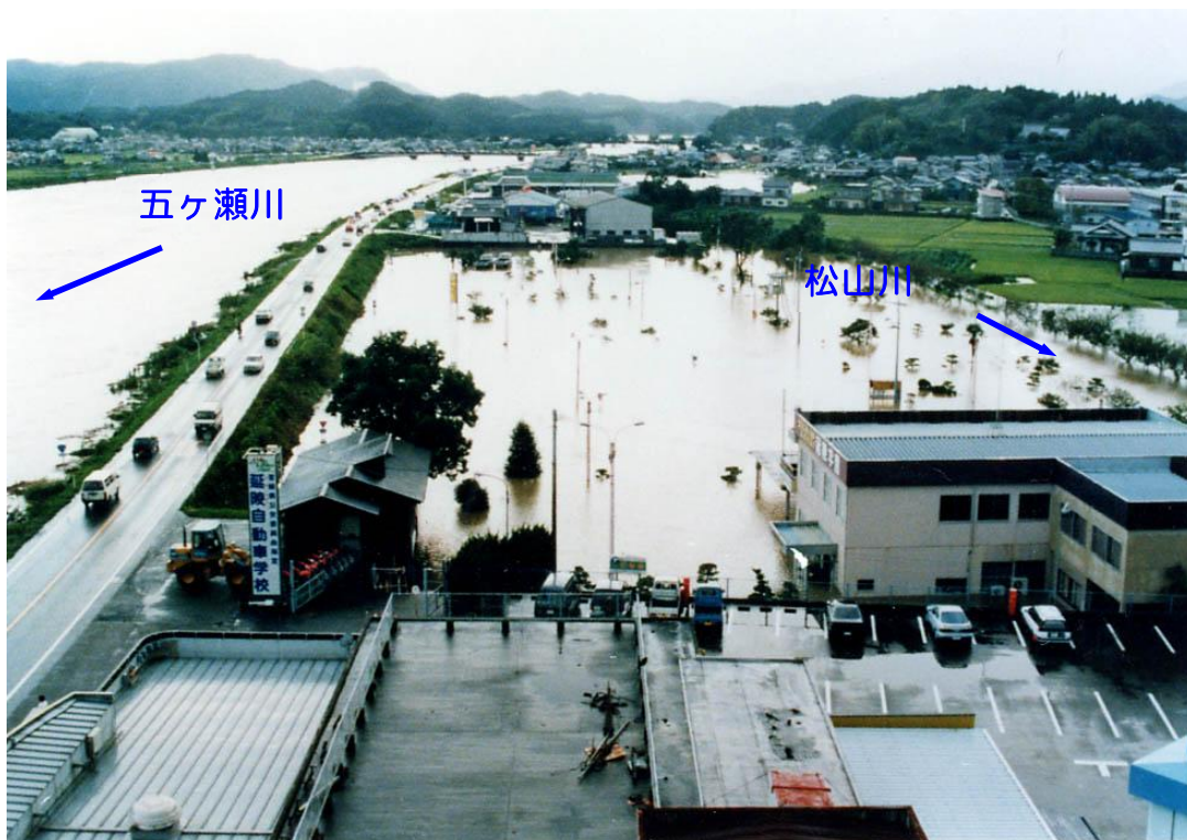
平成 9 年（1997 年）9 月洪水による支川 まつやま 松山川中流部の被災状況
