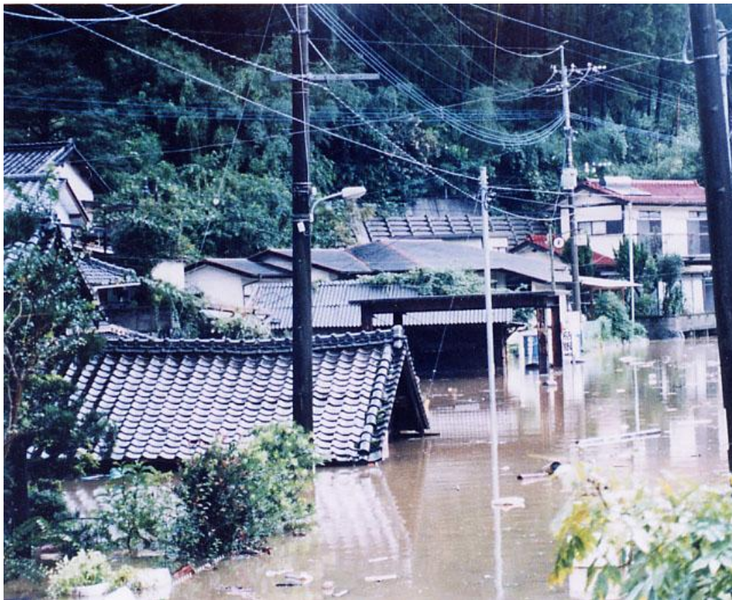
平成 5 年（1993 年）8 月洪水による支川 そきがわ 曾木川沿い しもそき 下曾木地区の被災状況
