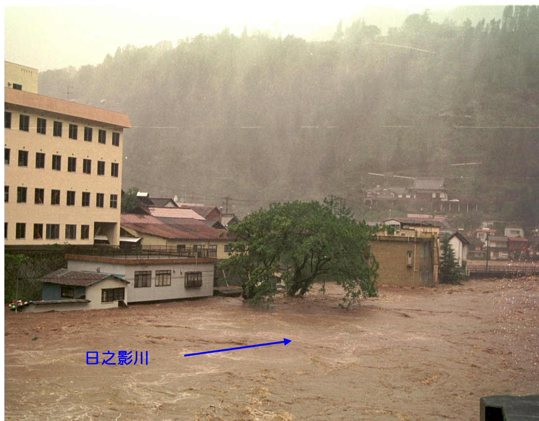
平成 17 年（2005 年）9 月洪水による支川日之影川沿い ひのかげ 日之影地区の被災状況
