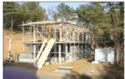
2 方向ラーメン施工試験
