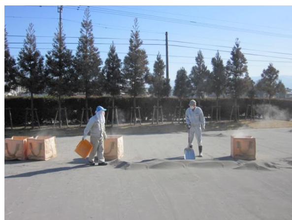
新燃岳火山灰処理作業（平成 23 年 1 月）
