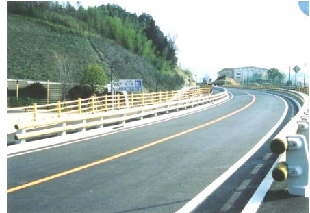
木製ガードレール
