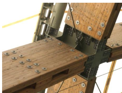
木の花ドームの接合部
