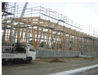
工場の軸組み
