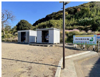
区で整備した 防災広場
