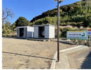
区で整備した 防災広場
