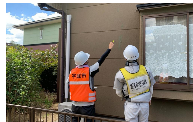
住家被害認定調査の様子
