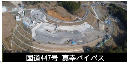
国道447号 真幸バイパス
