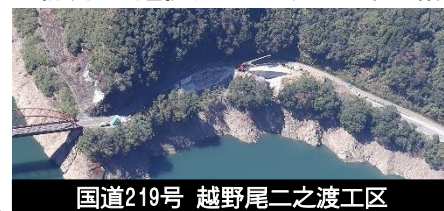
国道219号 越野尾二之渡工区
