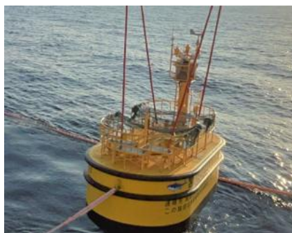
図2 表層型浮魚礁の設置
