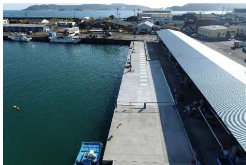
図10 漁港施設の地震・津波対策
