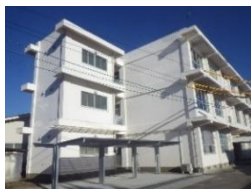
校舎の外壁改修
