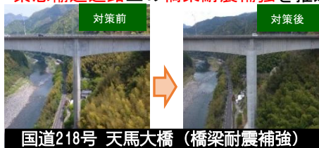
国道218号 天馬大橋 (橋梁耐震補強)
