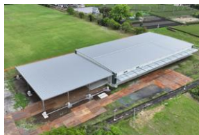
災害支援物資拠点施設
