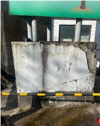
地面より上から撤去(根切り)し、 コンクリートにて舗装
