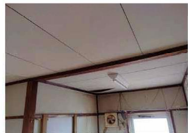
【天井】木材が使用されている
