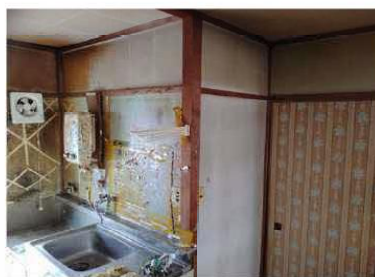
【壁】木材、石綿板が使用されている
