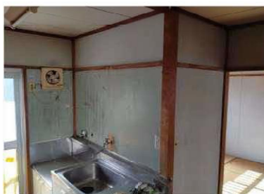
【壁】木材、石綿板が使用されている
