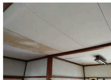
【天井】木材が使用されている
