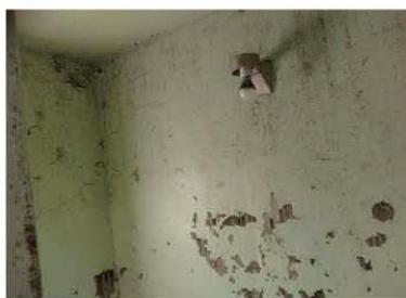
【壁】モルタル、塗料が使用されている
