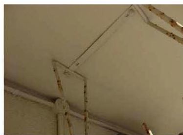
【天井】仕上塗材が使用されている
