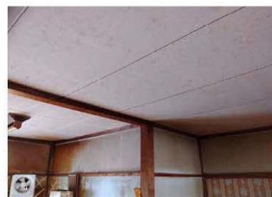
【天井】木材が使用されている
