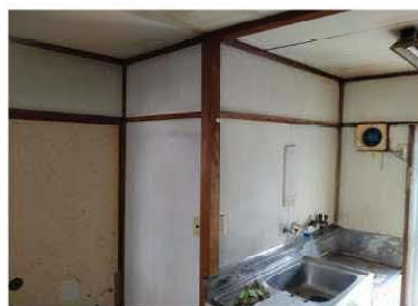
【壁】木材、石綿板が使用されている
