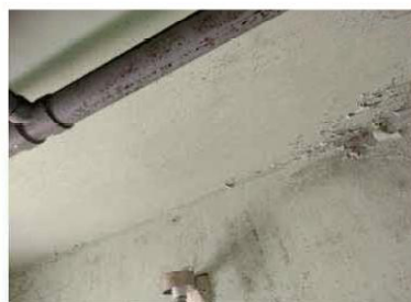
【天井】モルタル、塗料が使用されている
