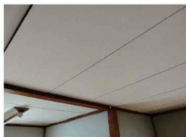
【天井】木材が使用されている
