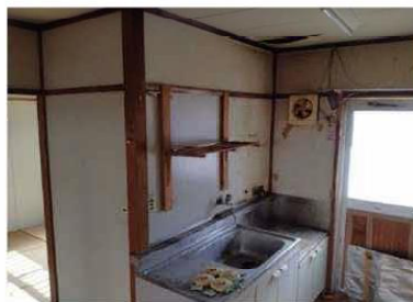
【壁】木材、石綿板が使用されている
