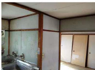
【壁】木材、石綿板が使用されている
