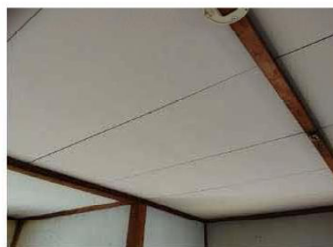
【天井】木材が使用されている
