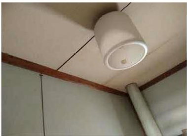
【天井】木材が使用されている
