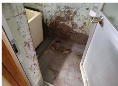
【床】コンクリートが使用されている
