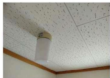
【天井】ジブトーンが使用されている
