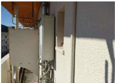
【壁】吹付タイル、隔壁板が使用されている
