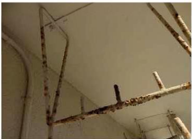
【天井】仕上塗材が使用されている
