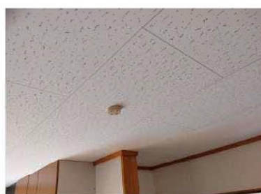
【天井】ジプトーンが使用されている
