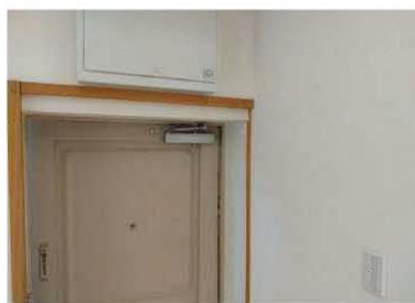
【壁】石膏ボードが使用されている
