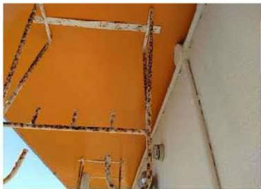
【天井】仕上塗材が使用されている
