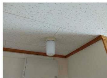
【天井】ジプトーンが使用されている
