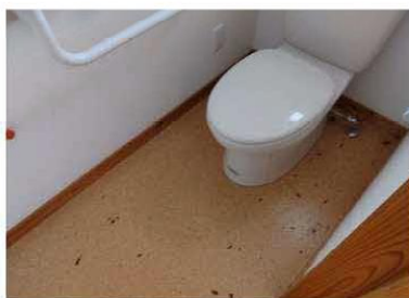
【床】長尺シートが使用されている
