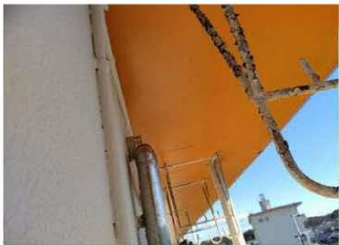
【天井】仕上塗材が使用されている
