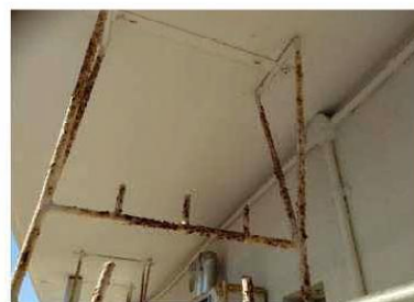
【天井】仕上塗材が使用されている
