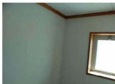
【壁】石膏ボードが使用されている
