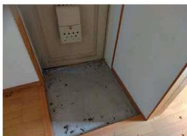
【床】コンクリートが使用されている
