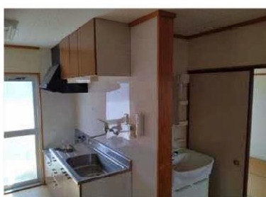
【壁】石膏ボード、キッチンパネルが使用されている
