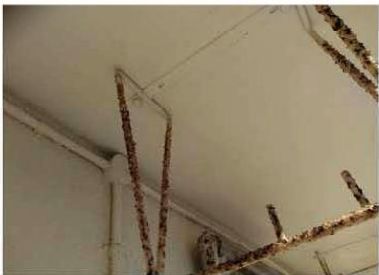
【天井】仕上塗材が使用されている
