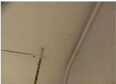
【天井】仕上塗材が使用されている
