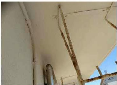
【天井】仕上塗材が使用されている
