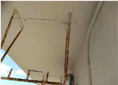
【天井】仕上塗材が使用されている
