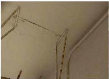
【天井】仕上塗材が使用されている
