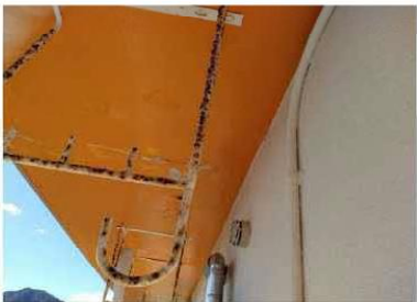
【天井】仕上塗材が使用されている
