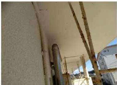
【天井】仕上塗材が使用されている
