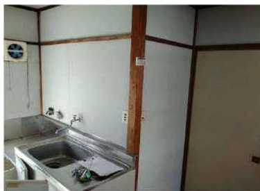
【壁】木材、石綿板が使用されている
