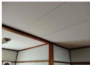
【天井】木材が使用されている
