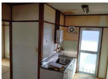
【壁】木材、石綿板が使用されている
