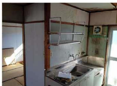
【壁】木材、石綿板が使用されている
