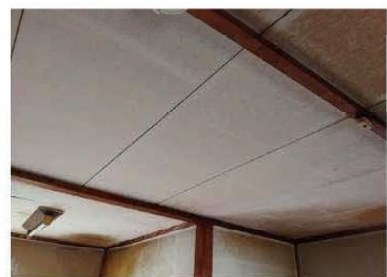
【天井】木材が使用されている
