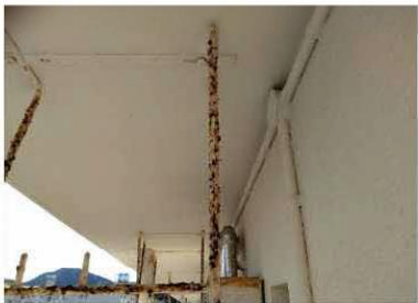
【天井】仕上塗材が使用されている
