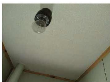
【天井】石膏ボードが使用されている
