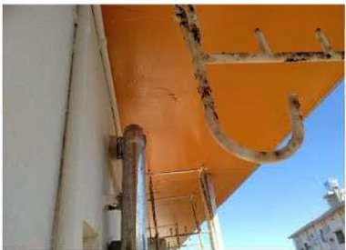
【天井】仕上塗材が使用されている
