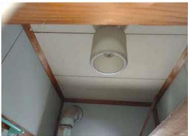
【天井】木材が使用されている
