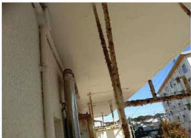
【天井】仕上塗材が使用されている
