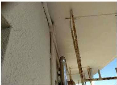
【天井】仕上塗材が使用されている
