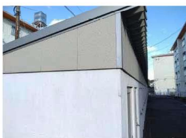
【壁】仕上塗材、サイディングボードが使用されている
