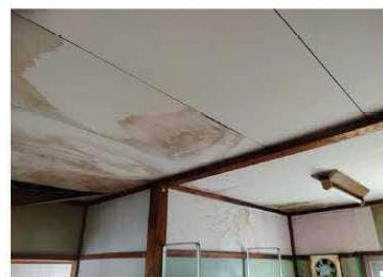
【天井】木材が使用されている
