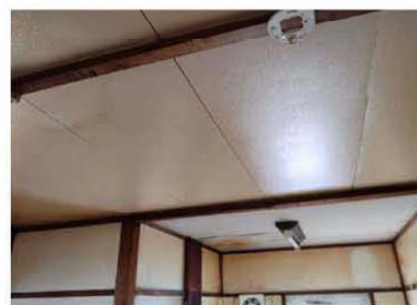
【天井】木材が使用されている
