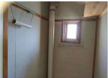
【壁】木材が使用されている
