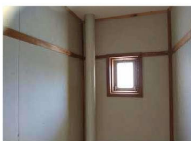
【壁】木材が使用されている
