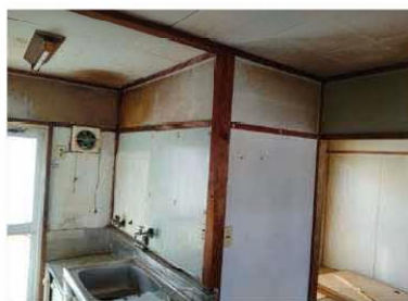
【壁】木材、石綿板が使用されている
