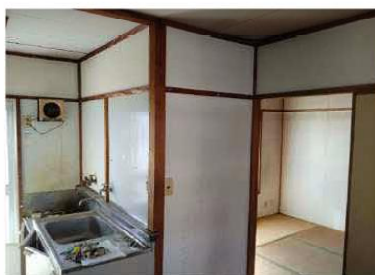
【壁】木材、石綿板が使用されている
