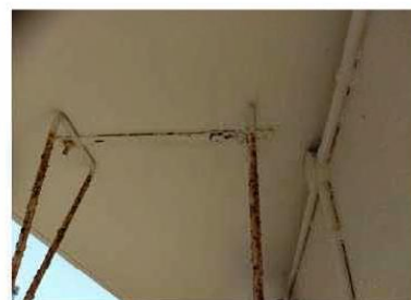
【天井】仕上塗材が使用されている
