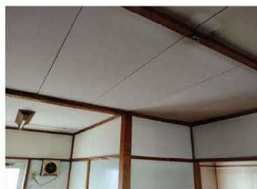
【天井】木材が使用されている
