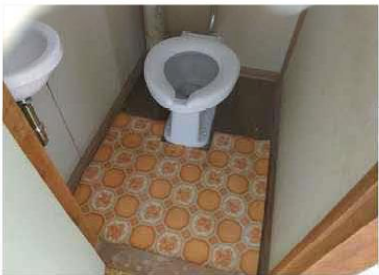
【床】木材、長尺シートが使用されている
