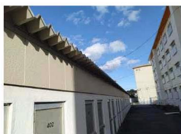
【天井】折板が使用されている
