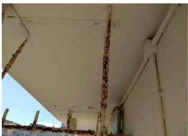
【天井】仕上塗材が使用されている
