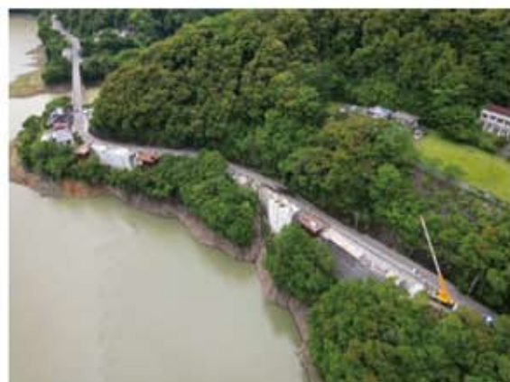
国道219号 越野尾二之渡工区
