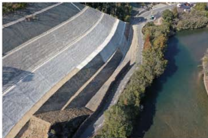
岩戸延岡線 黒岩工区
