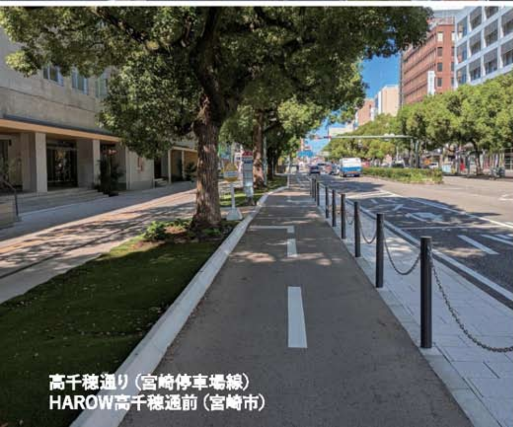
有永山之口停車場線 山之口運動公園前工区（都城市）
