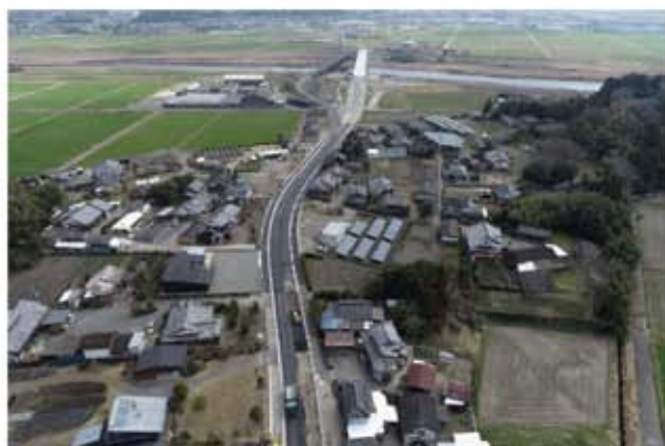
高城山田線 王子橋
