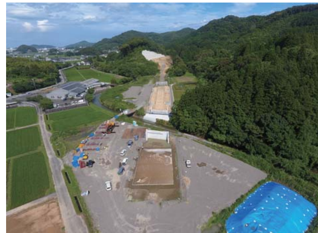
国道327号 永田工区
