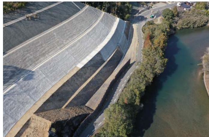
岩戸延岡線 黒岩工区
