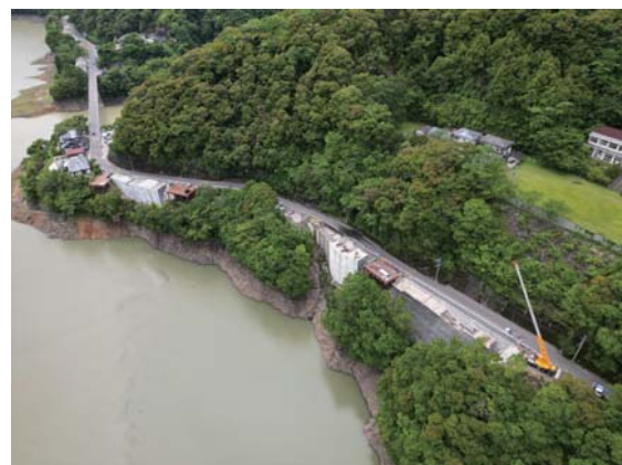
国道219号 越野尾二之渡工区
