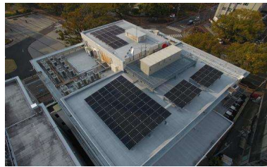
1-(2) 7号館屋上に太陽光パネル設置
