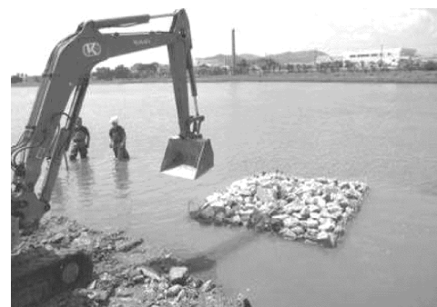
石倉設置の様子
