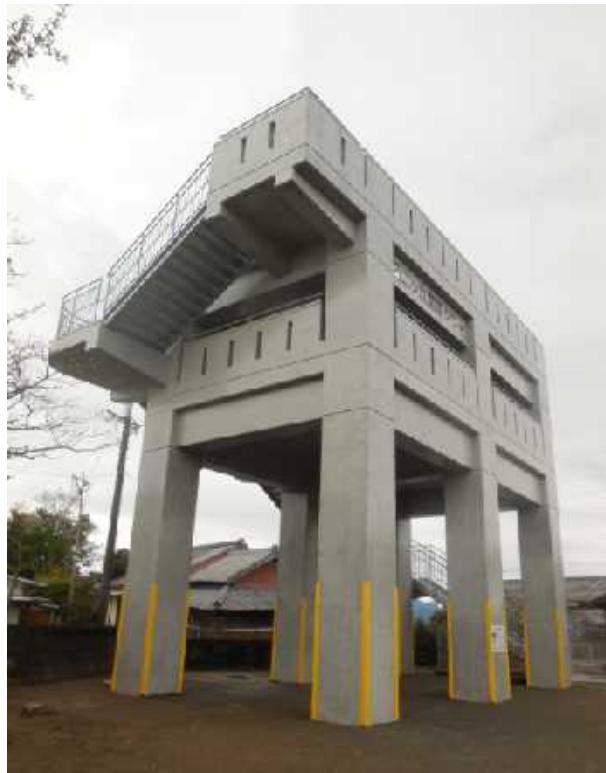
津波避難タワー
