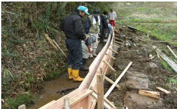
共同での直営水路改修作業
