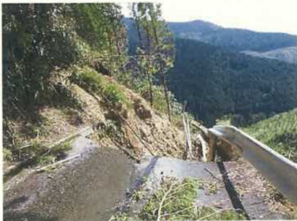
国道265号（椎葉村大字大河内）
