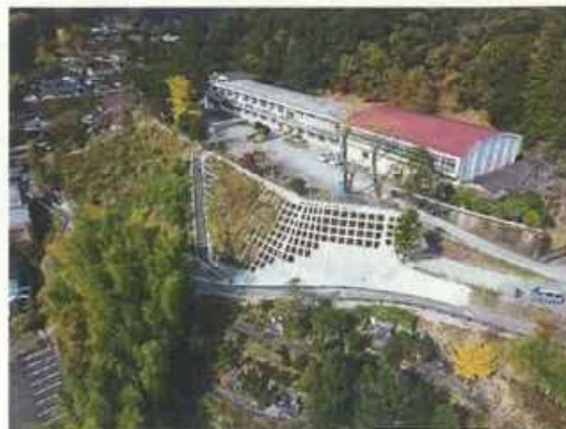
西米良村（鶴地区）急傾斜対策工事
