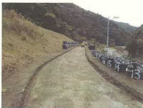
仮設道設置工事（主要地方道西都南郷線）
