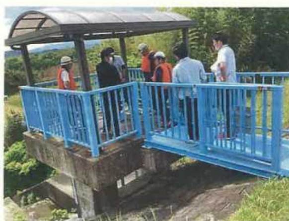
出水期前の水門点検（竹淵排水樋門）
