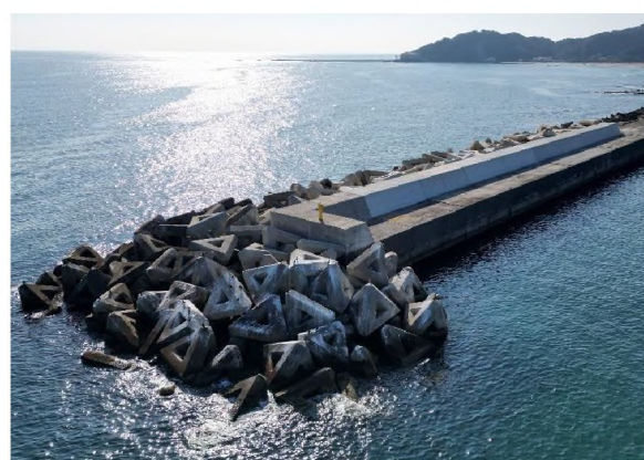
沖防波堤(完成)
