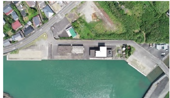
－2m物揚場(完成)
