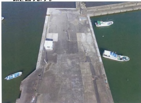
第2物揚場(着手前)
