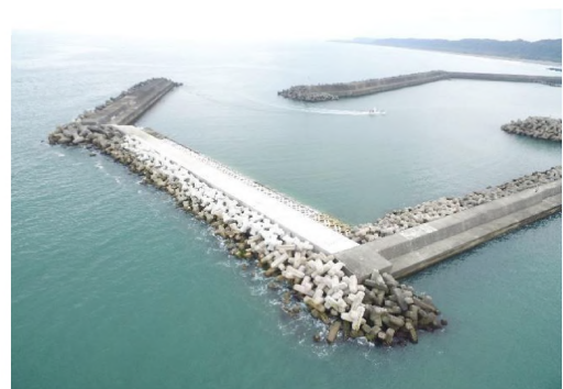
北沖防波堤(完成)
