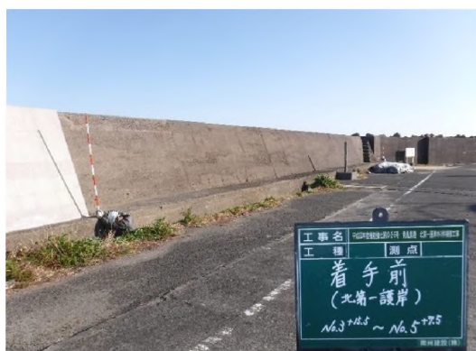
北第一護岸(着手前)
