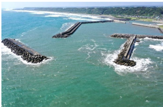
北沖防波堤(着手前)
