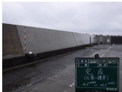
北第一護岸(完成)
