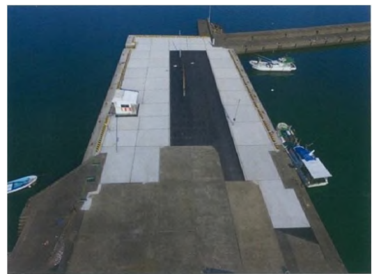
第2物揚場(完成)
