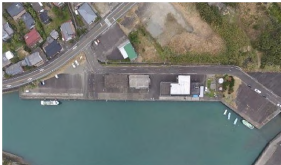
－2m物揚場(着手前)
