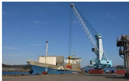
▲コンテナ船荷役状況
