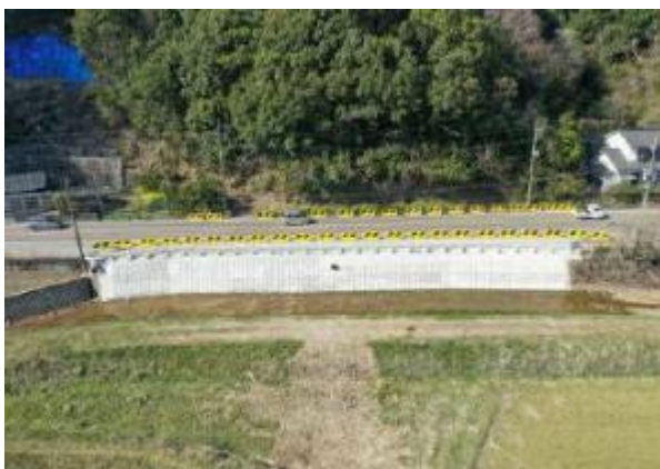
兼用護岸補強（国道 327 号日向市永田）
