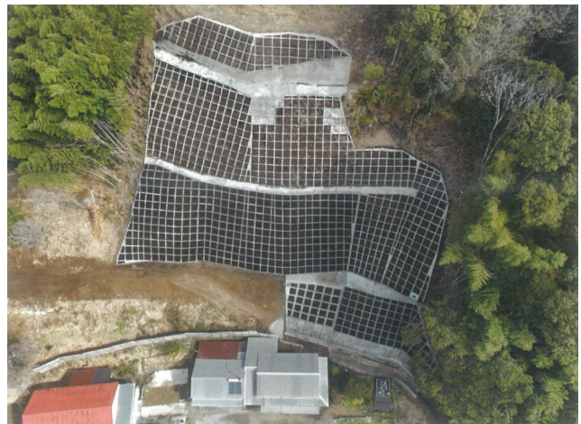
令和7年3月 施工中
