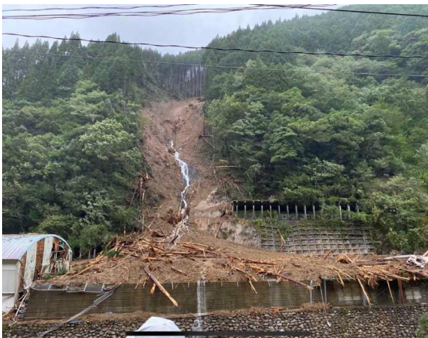
椎葉村 鹿野遊谷川 被災状況(R2. 9. 7)
