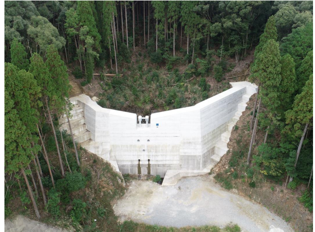
鵜毛谷川 2 令和 7 年 3 月 施工中
