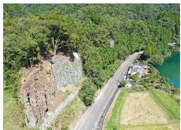
斜面補強（国道 388 号門川町熊毛田）
