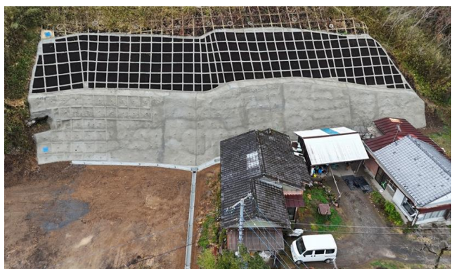
令和 7 年 3 月 施工中
