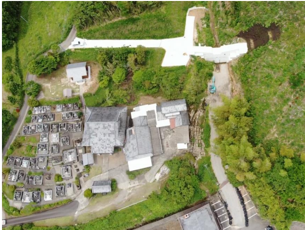
黒木谷川 令和 7 年 3 月 施工中
