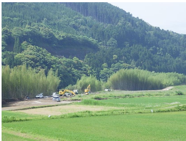
丸口地区（築堤工事）
