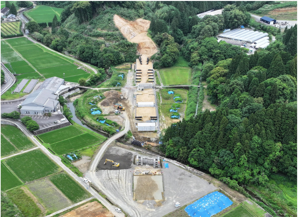
国道327号 永田バイパス（永田地区）（令和7年6月撮影）
