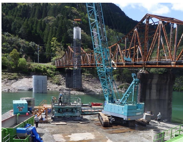
福瀬大橋（橋梁架替事業）
