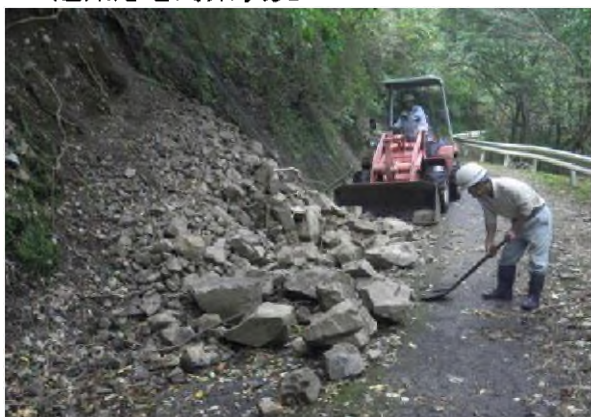
<道路応急対策状況>
