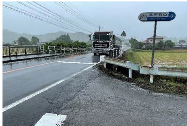
<嵐田工区> 着手前
