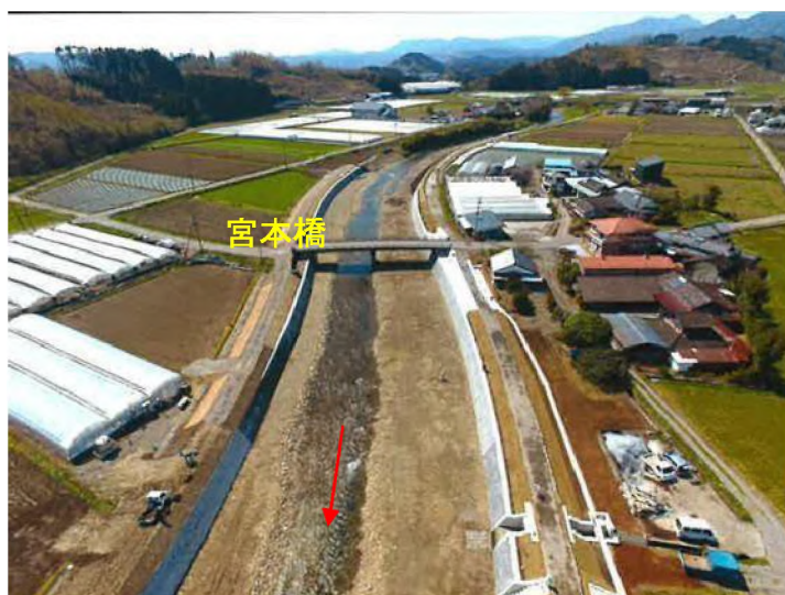
完成（宮本橋上下流）
