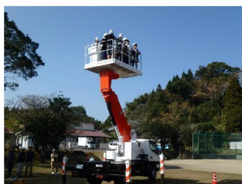
高所作業車体験
