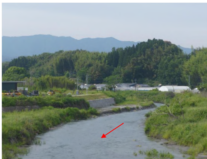
河道の拡幅 〈深年川施工中(須志田橋上流)〉
