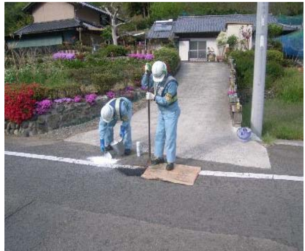
路面の応急補修
