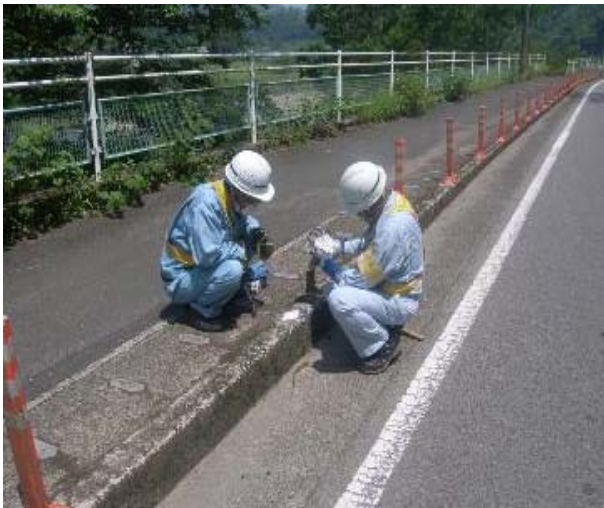
道路施設の補修
