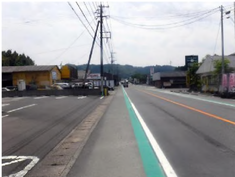
歩道工事(国道221号麓工区 着手前)
