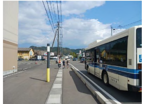
歩道工事(国道221号麓工区 令和6年度 完成)
