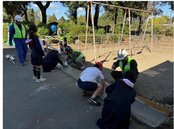
コンクリート補修体験の様子
