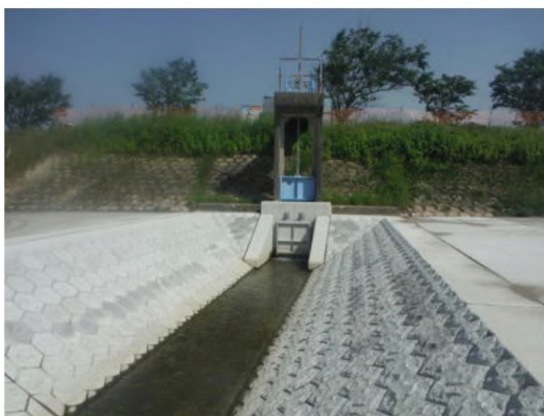
福島川 寺園樋門
