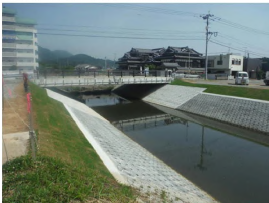
国道220号松清橋付近
