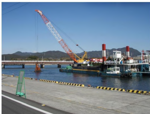
福島港（泊地浚渫状況）
