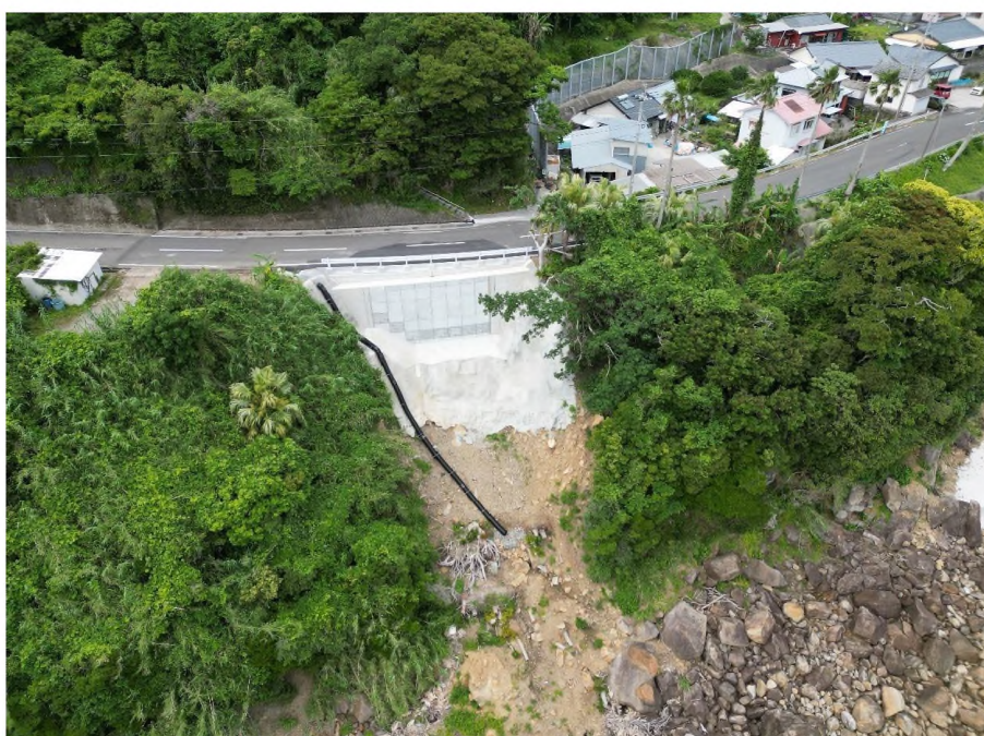
令和7年度完成 一般国道448号 道路災害復旧工事(PCW工法)
