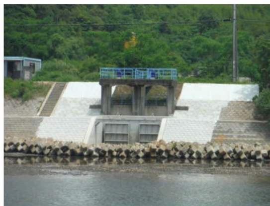
福島川 7号樋門
