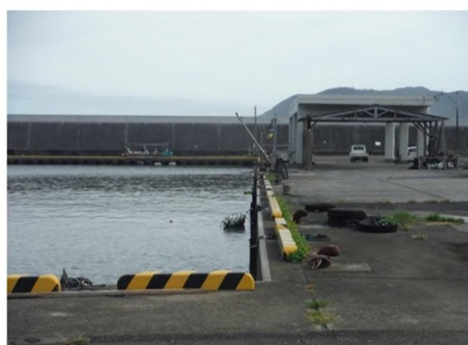
第5物揚げ場（耐震補強）
