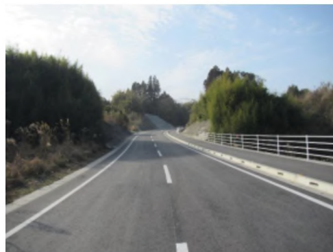
令和4年度改良区間
