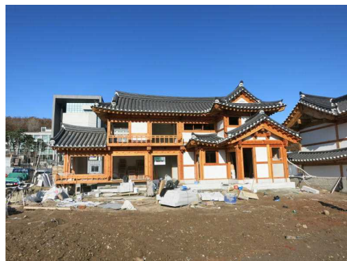
韓国の伝統的住宅「韓屋」
