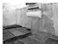
簡易冷房育苗施設
