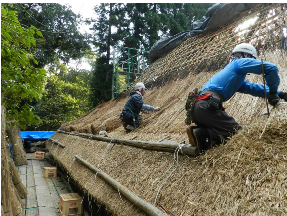
萱の葺き替え作業
