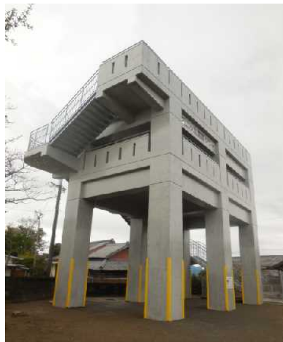
津波避難タワー
