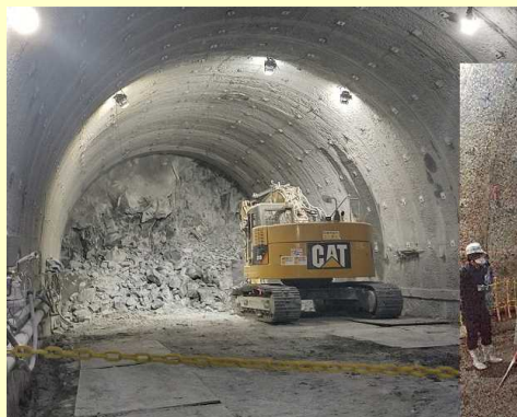
▲真幸トンネル内部の掘削状況
