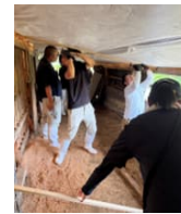
【遮熱シート設置の様子】
