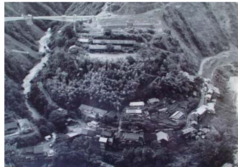
ダム湖に沈んだ越野尾地区
