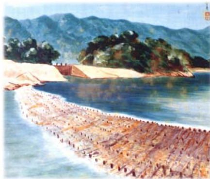
第一期工事が完成(かご堰)*1
