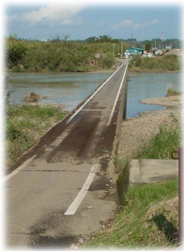
潜水橋には欄干が無い（柳瀬潜水橋）
