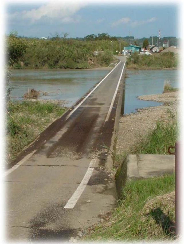
潜水橋には欄干が無い（柳瀬潜水橋）
