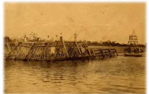
水制工組み立て風景
