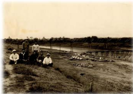
工事現場の風景
