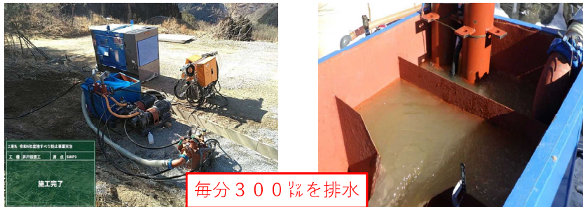
(写真2 スーパーウェルポイント工法)
