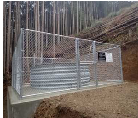
(写真3 集水井工完成イメージ)
