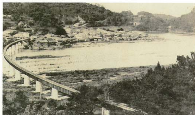
完成した鉄橋
