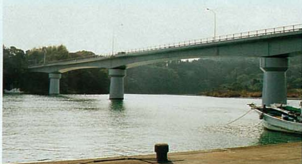
美々津大橋
