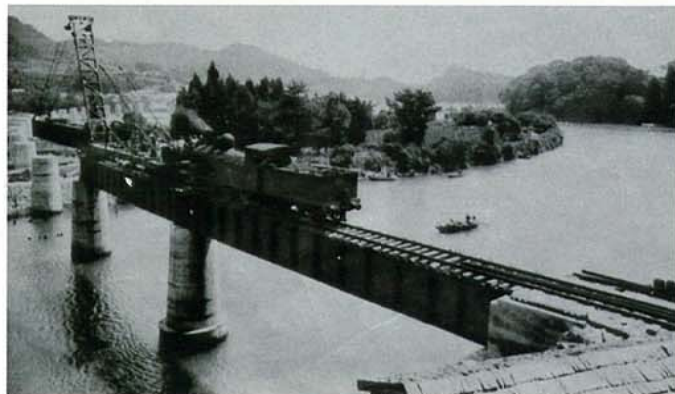
工事中の鉄橋
