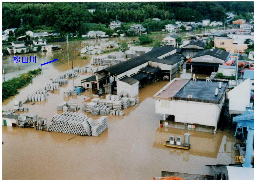
平成9年（1997年）9月洪水による支川松山川下流部の被災状況 まつやま
