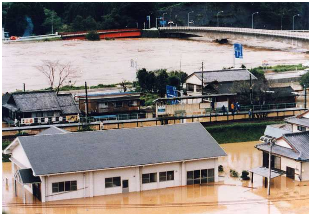
平成 5 年（1993 年）8 月洪水による五ヶ瀬川本川沿い細見地区の被災状況 ほそみ
