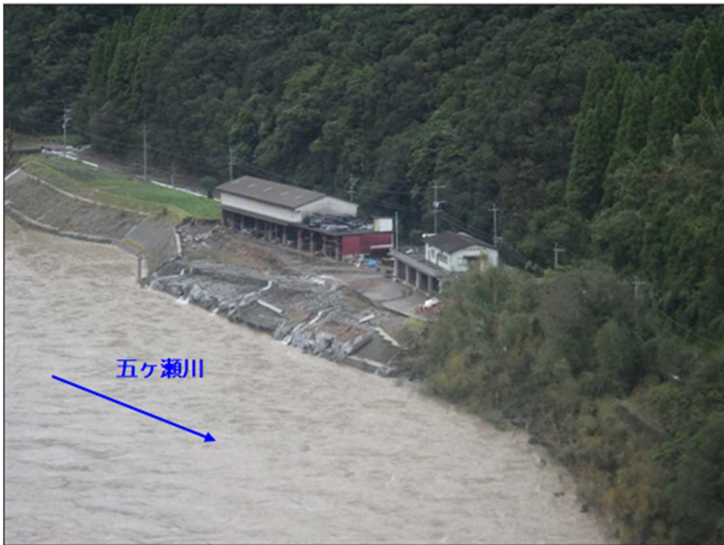
令和4年（2022年）9月洪水による五ヶ瀬川本川沿い蔵田地区 くらた の被災状況
