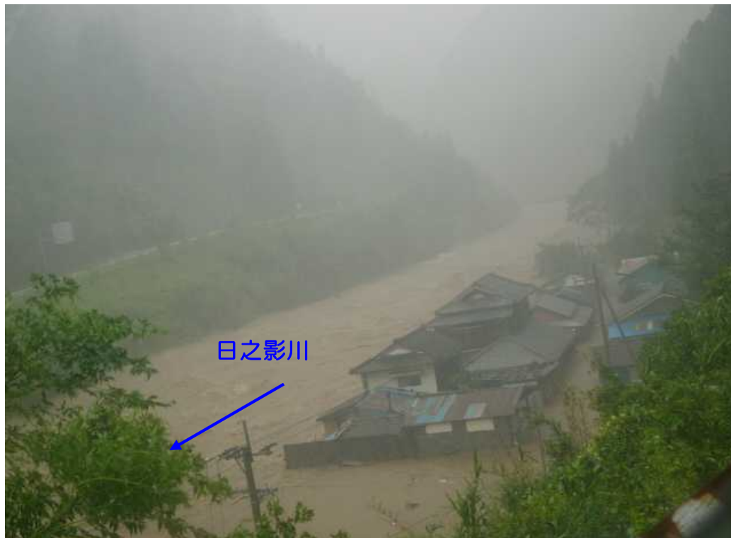
平成 17 年（2005 年）9 月洪水による支川日之影川沿い上日之影地区の被災状況 かみひのかげ
