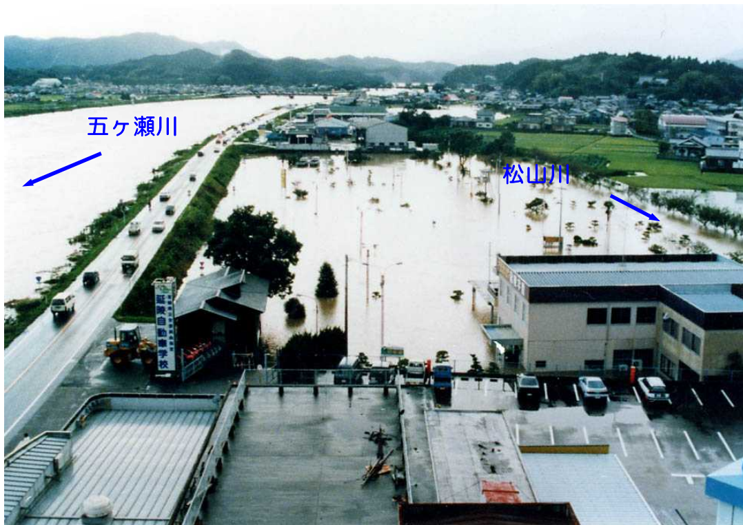
平成9年（1997年）9月洪水による支川松山川中流部の被災状況 まつやま
