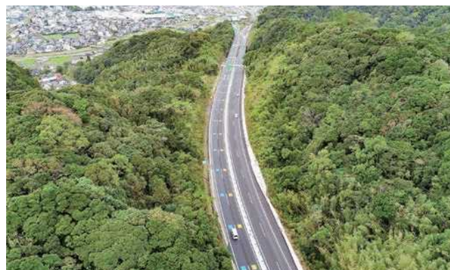
鹿児島県 隼人道路4車線化
