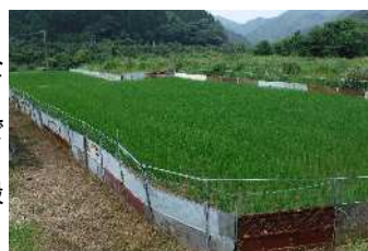
トタン柵の設置事例
