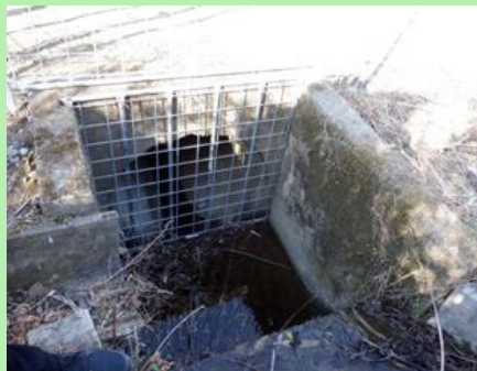
水路の侵入防止対策
