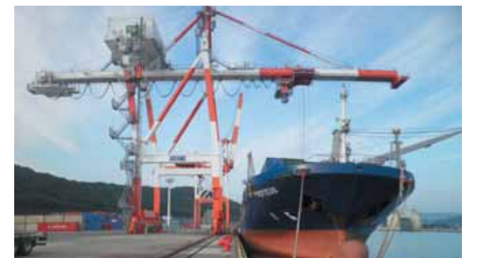
▲ガントリークレーン
