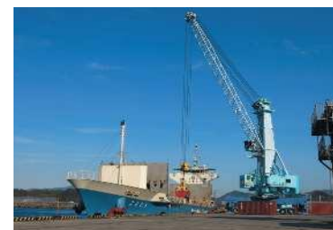
▲コンテナ船荷役状況
